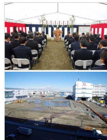
約50名が起工式に参列(写真上) 解体工事が完了した敷地(写真下)
